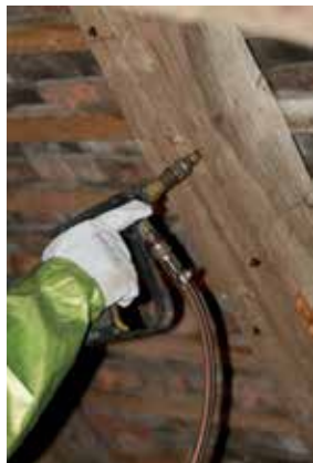
Charpente traditionnelle : pulvérisation surface et injection au cœur du bois
