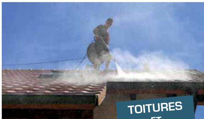
Assainit les tuiles et retarde le développement des mousses.
